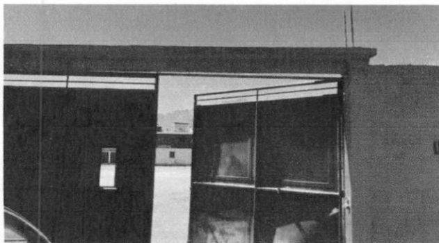
Foto 1: Sustitución de porton principal
