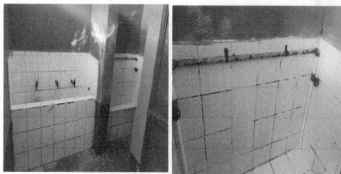
Foto 8: Sustitución de migitorio, llaves, grifos y accesorios
