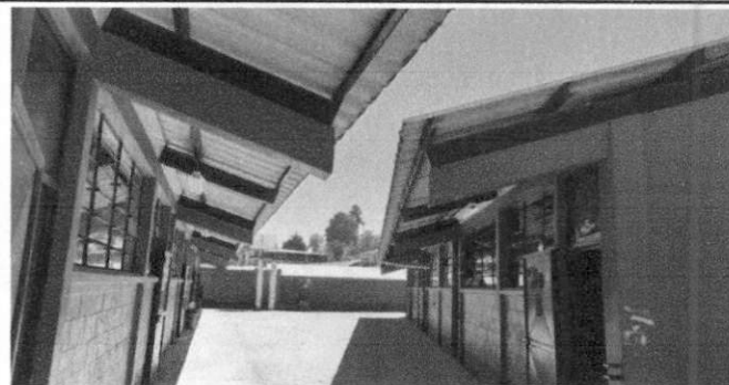
Foto 10: Sustitución de canales de PVC y soporte opescente para canal
