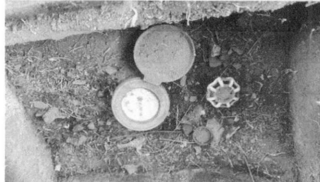
Foto 2: Sustitución de Contador de agua, linea principal, llave de globo, llave de cheque y caja
