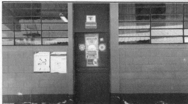
Foto 7: Mantenimiento de puerta de Dirección y siete aulas
